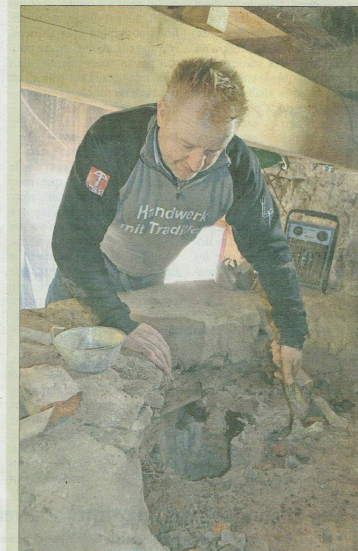
L'artisan Gregor Origoni, de Büron, dans le canton de Lucerne, s'active à démonter la voûte qui menaçait de s'effondrer.
