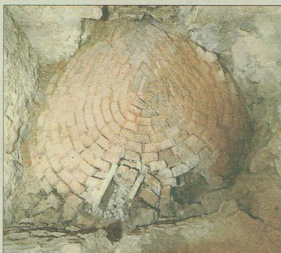
La nouvelle voûte installée par l'artisan.
